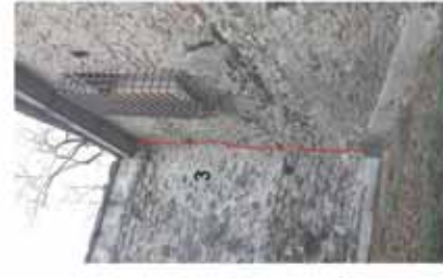
Le analisi termografiche permettono di affermare che la fessura 1 è passante. Al contrario, non si hanno informazioni aggiuntive sulla fessura 2, sito in un'area non rilevabile. Non conoscendo le passate condizioni di carico e possibile ipotizzare che queste siano causate dal sovraccarico in fondazione dovuto alla realizzazione del corpo di fabbrica all'interno della corte.
