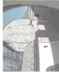
L'analisi dei giunti 1 e 2 mette in luce il mancato ammorciamento fra la muratura della torre e quelli dei corpi adossati.
